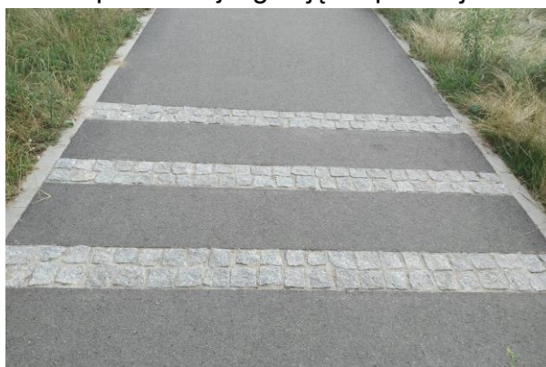
Fot. Obiekt spowalniający na ścieżce rowerowej – przekładki z kostki kamiennej granitowej
