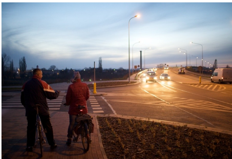
Fot. 66. Tuż przed wjazdem na wiadukt ulicy Przemysłowej, nad linią kolejową i ulicą Podmiejską. Ścieżka rowerowa znów przechodzi na prawą stronę ul. Przemysłowej, co wymusza konieczność przejazdu przez dwa skrzyżowania z jezdnią bardzo ruchliwej ulicy. Wielu rowerzystów tego nie robi i kontynuuje jazdę po lewej stronie ulicy Przemysłowej chodnikiem, dzieląc przestrzeń z pieszymi.
