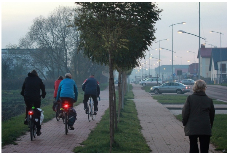
Fot. 63 Wydzieloną drogą dla rowerów wzdłuż ul. Kasprowicz. Latarnie wzdłuż tej ulicy zainstalowane są w taki sposób, że oświetlają chodnik i jezdnię, ale ich światło, niestety, nie dochodzi do drogi dla rowerów, oddzielonej od chodnika pasem zieleni.
