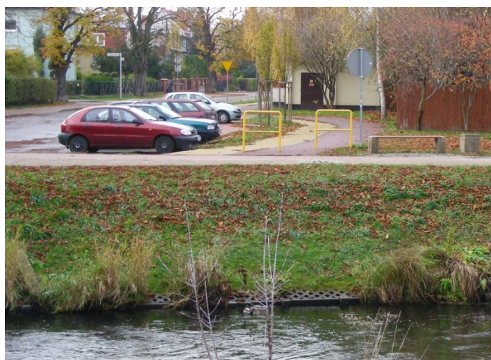
Fot. 41. Przejazd na drugi brzeg Raduni mostkiem przy wylocie ul. Mickiewicza, wzdłuż której prowadzi droga dla rowerów (chodnik pieszo-rowerowy) z barierkami chroniącymi przed wjazdem do rzeki
