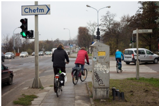
Fot. 10. po lewej i fot. 11. po prawej: skrzyżowanie korytarza ruchu rowerowego na Trakcie Św. Wojciecha z ul. Zarosław. Występujące utrudnienie postaci krawężnika. Po przekroczeniu skrzyżowania brakuje naturalnego płynnego połączenia trasy z jej dalszym ciągiem, w wyniku czego powstało wydepczyisko utworzone przez rowerzystów.
