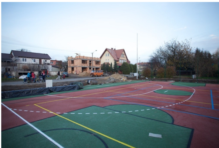
Fot. 61 Będący trakcie budowy zespół boisk i placów zabaw, w pobliżu których powinny powstać odpowiednie udogodnienia do parkowania rowerów przeznaczone dla osób korzystających z tego obiektu
