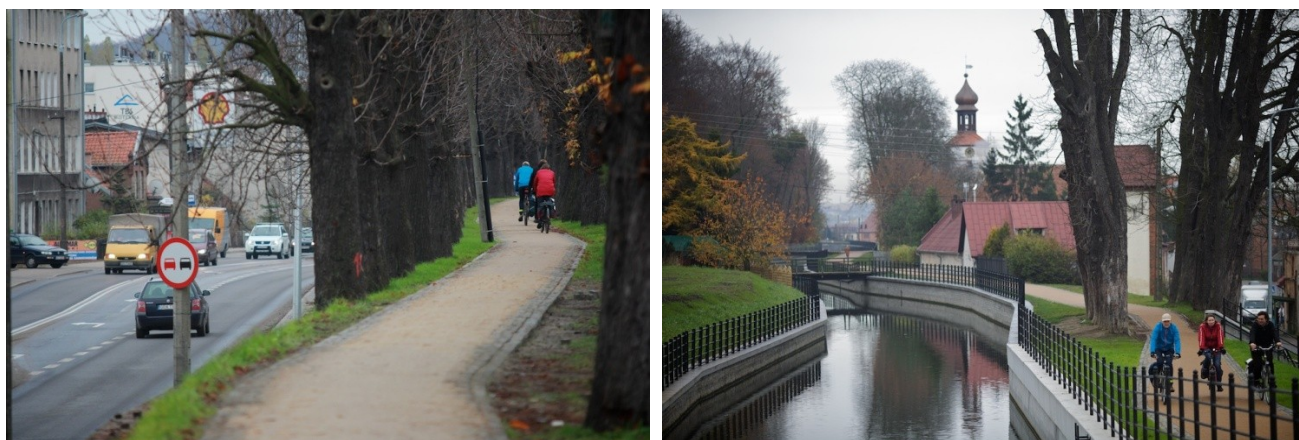
Fot. 16. po lewej i fot. 17. po prawej: droga techniczna wzdłuż korony wału przeciwpowodziowego kanału Raduni, w większości zrealizowana i przejezdna prawie do granicy Gdańska z Pruszczem Gdańskim.
