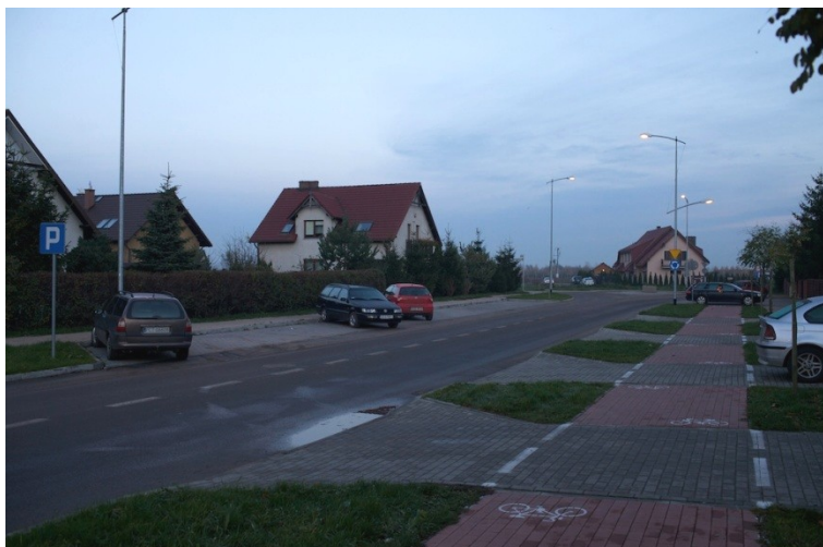
Fot. 5. Przykład przecięcia drogi rowerowej przez wjazdy do posesji, sugerujące podporządkowanie ruchu rowerowego ruchowi samochodowemu
