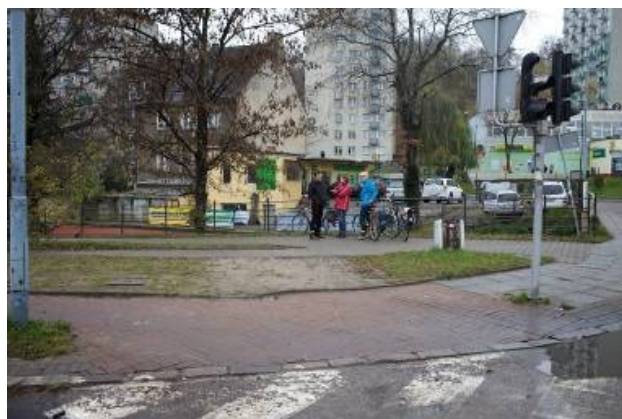
Fot. 10. po lewej i fot. 11. po prawej: skrzyżowanie korytarza ruchu rowerowego na Trakcie Św. Wojciecha z ul. Zarosław. Występujące utrudnienie postaci krawężnika. Po przekroczeniu skrzyżowania brakuje naturalnego płynnego połączenia trasy z jej dalszym ciągiem, w wyniku czego powstało wydepczyisko utworzone przez rowerzystów.
