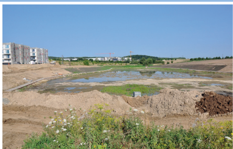
Zbiornik retencyjny na Osiedlu Bursztynowym
