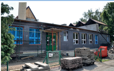
Termomodernizacja Przedszkola nr 4
