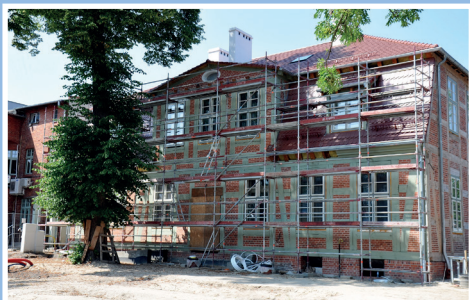
Budynek przy ul. Krótkiej 6
