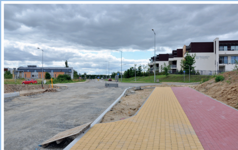
Budowa ul. Strzeleckiego (lipiec 2017)
