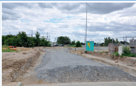
Budowa ul. Romera (lipiec 2017)
