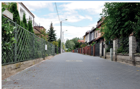
ul. Głowackiego po przebudowie
