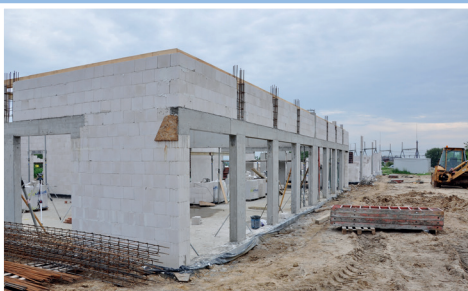
Budowa żłobka przy ul. Romera (sierpień 2017)
