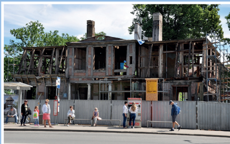
Remont budynku przy ul. Krótkiej 6 (lipiec 2017)
