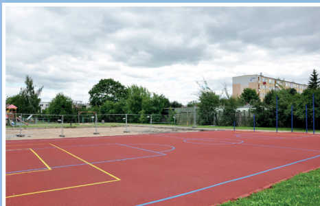
Modernizacja boiska przy ul. Tysiąclecia (lipiec 2017)
