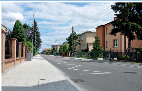
ul. Kochanowskiego po przebudowie
