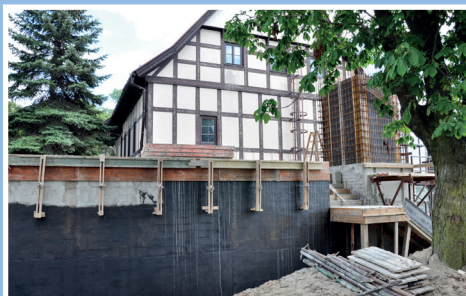
Przebudowa Centrum Kultury i Sportu (lipiec 2017)
