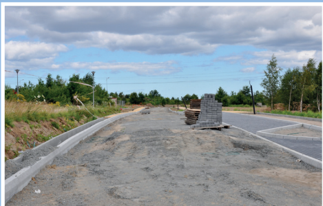
Budowa ul. Czekanowskiego (lipiec 2017)
