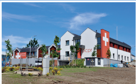
Budowa pogotowia ratunkowego (lipiec 2017)*
