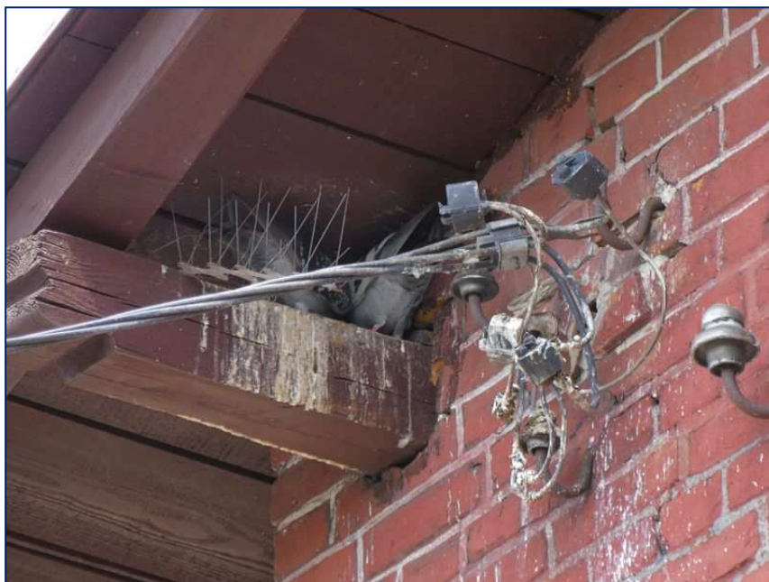
Fot. 4. Gołębie na budynku przy ulicy Fryderyka Chopina 18
