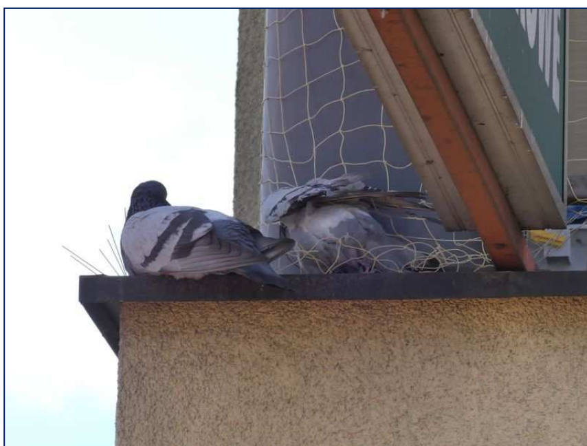
Fot. 10. Martwy gołąb zaplątany w siatkę na balkonie budynku przy Alei Księdza Józefa Waląga 3
