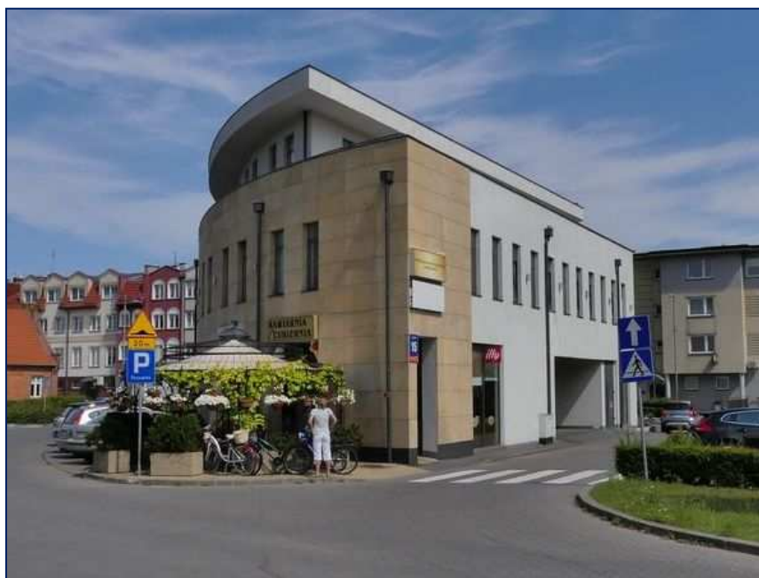
Fot. 23. Płaski dach i brak jakichkolwiek zabezpieczeń przed przebywaniem gołębi sprzyja przesiadywaniu tych ptaków na budynku przy ulicy Wojciecha Kossaka 15
