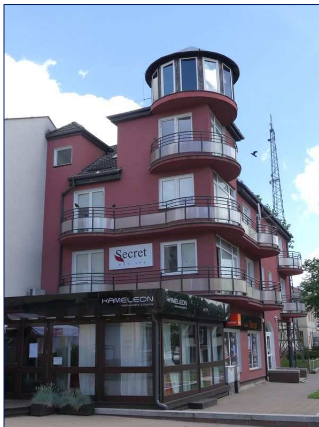
Fot. 11. Budynek przy Alei Księdza Józefa Waląga 5, na którym zamontowano własnoręcznie wykonane zabezpieczenia przed siadaniem gołębi zagrażające zdrowiu i życiu ptaków
