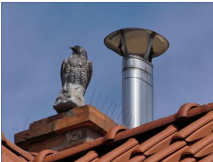
Fot. 21. Zabezpieczenie komina przed siadaniem gołębi komina budynku przy ulicy Wojciecha Kossaka 4
